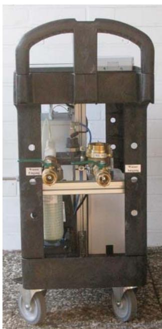
Die mobile Wasserdesinfektionsanlage **BAVIKI200mobil** besteht aus einer Chlordioxiderzeugungsanlage sowie einer Dosierstrecke. Die Komponenten sind fest auf einem Rollwagen montiert. Die Anlage kann als Sofortmaßnahme zur Bekämpfung von Legionellen oder zur Trinkwasserdesinfektion in Altenheimen, Schulen, Hotels oder in Mietshäusern mit erheblichen Leerständen eingesetzt werden.
